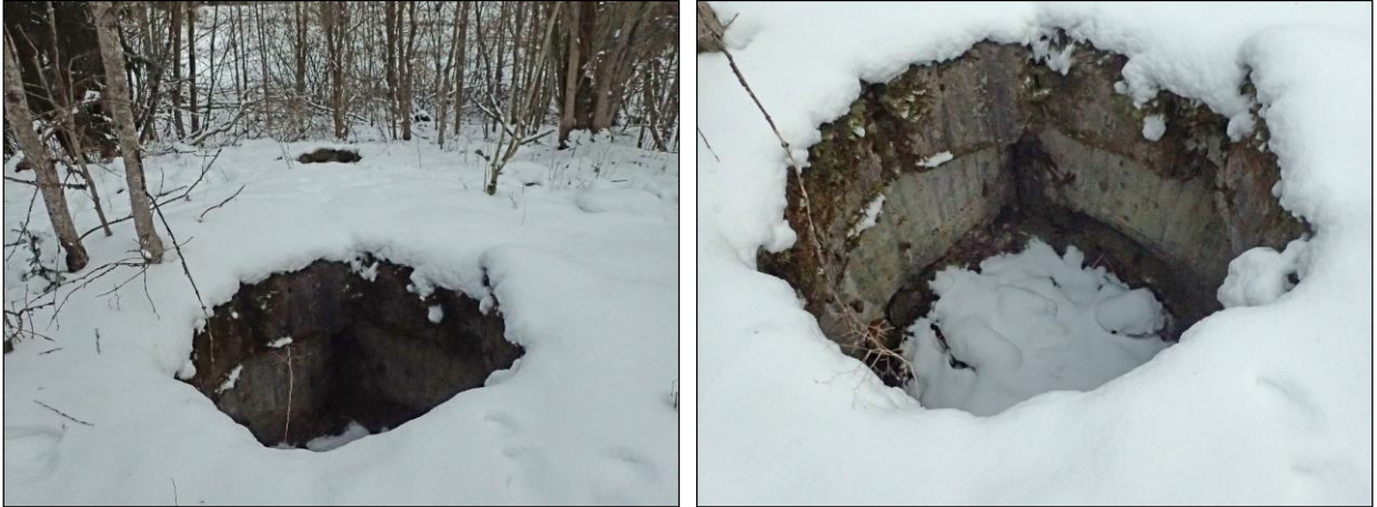
Aukko keskellä kattoa ja sen itäpuolella rinteessä pyöreä betonirakenne joka tukittu kivillä.
