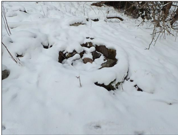
Aukko keskellä kattoa ja sen itäpuolella rinteessä pyöreä betonirakenne joka tukittu kivillä.
